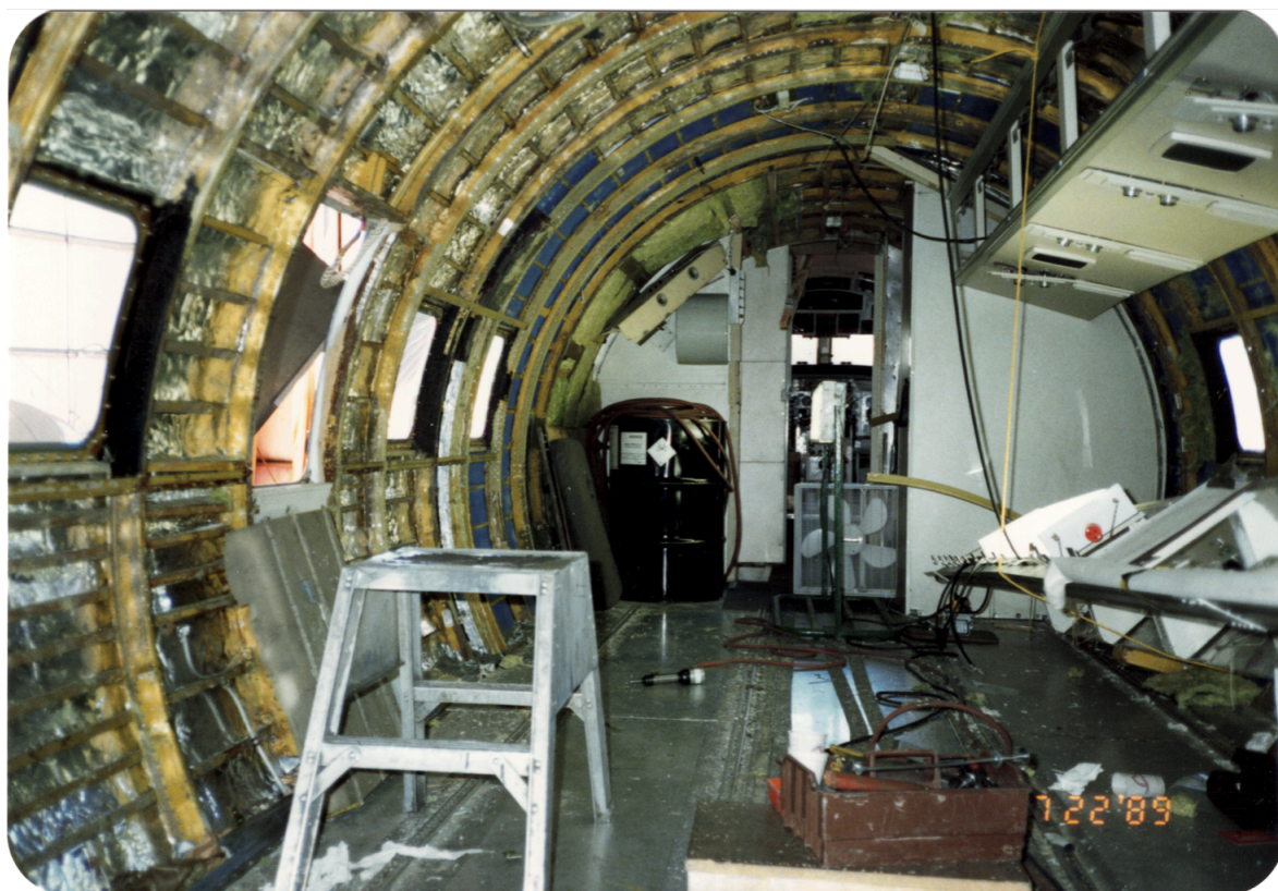
Bilde fra monteringen av interiøret, juli 1989.
